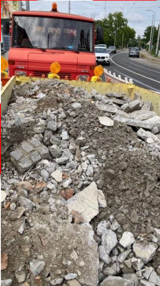
Container mit Betonbruch
