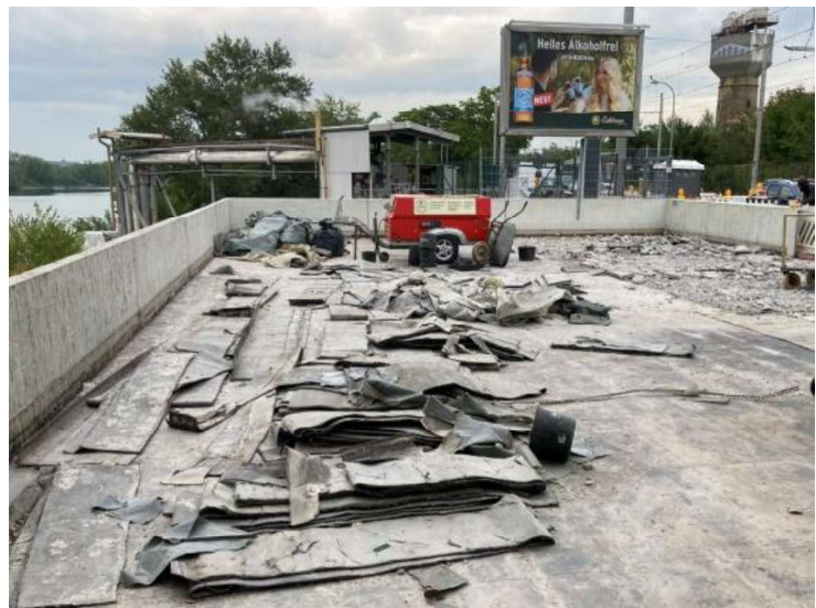
Abschälen Dichtbahnen
